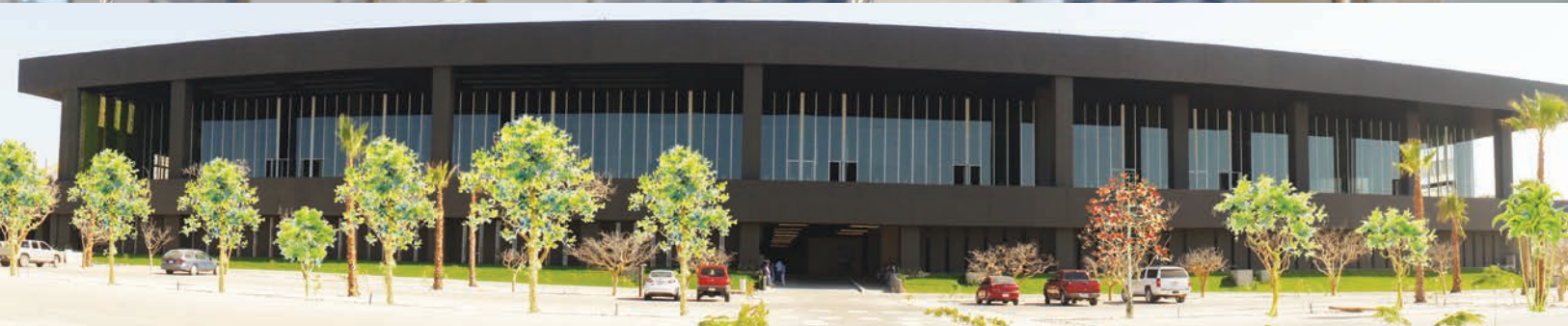
SISTEMA DE CABLES CENTRO DE CONVENCIONES LOS CABOS (G-20) Instalado por: TECNOVIDRIO
